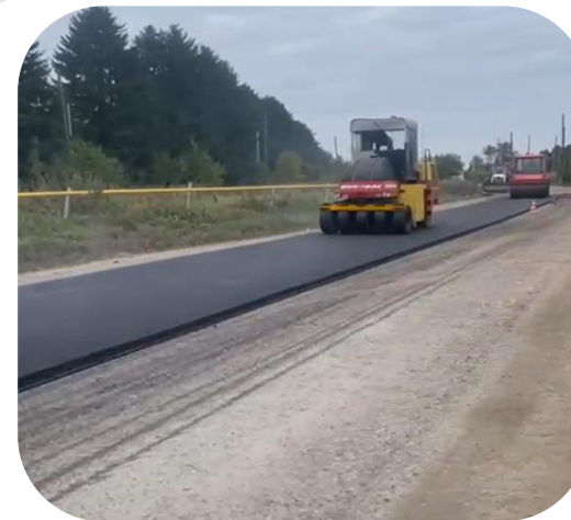
Дорога по ул. Мелиораторов в с. Култаево
