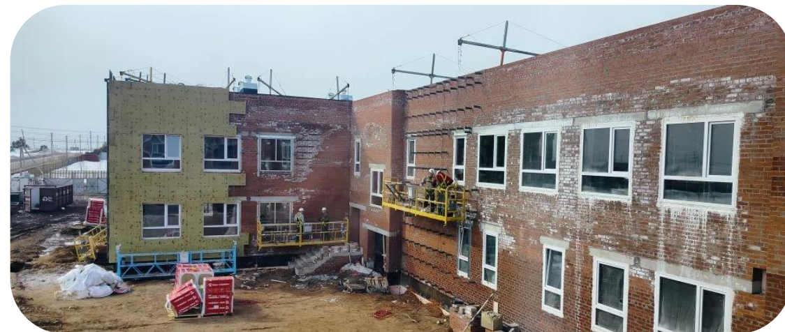
Строительство здания детского сада на 350 мест в д. Большая Мось
