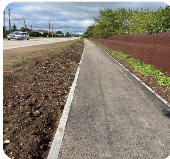
Ремонт тротуара по ул. Романа Кашина в с. Култаево
