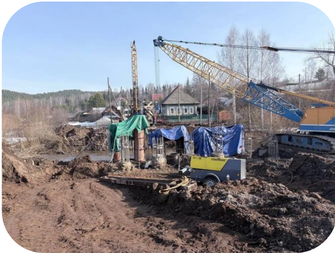
Капитальный ремонт моста через р. Мулянка д. Клестята
