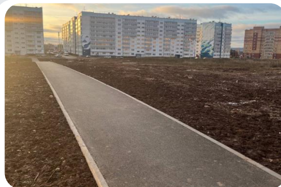
Устройство тротуара по ул. Солнечная в с. Фролы
