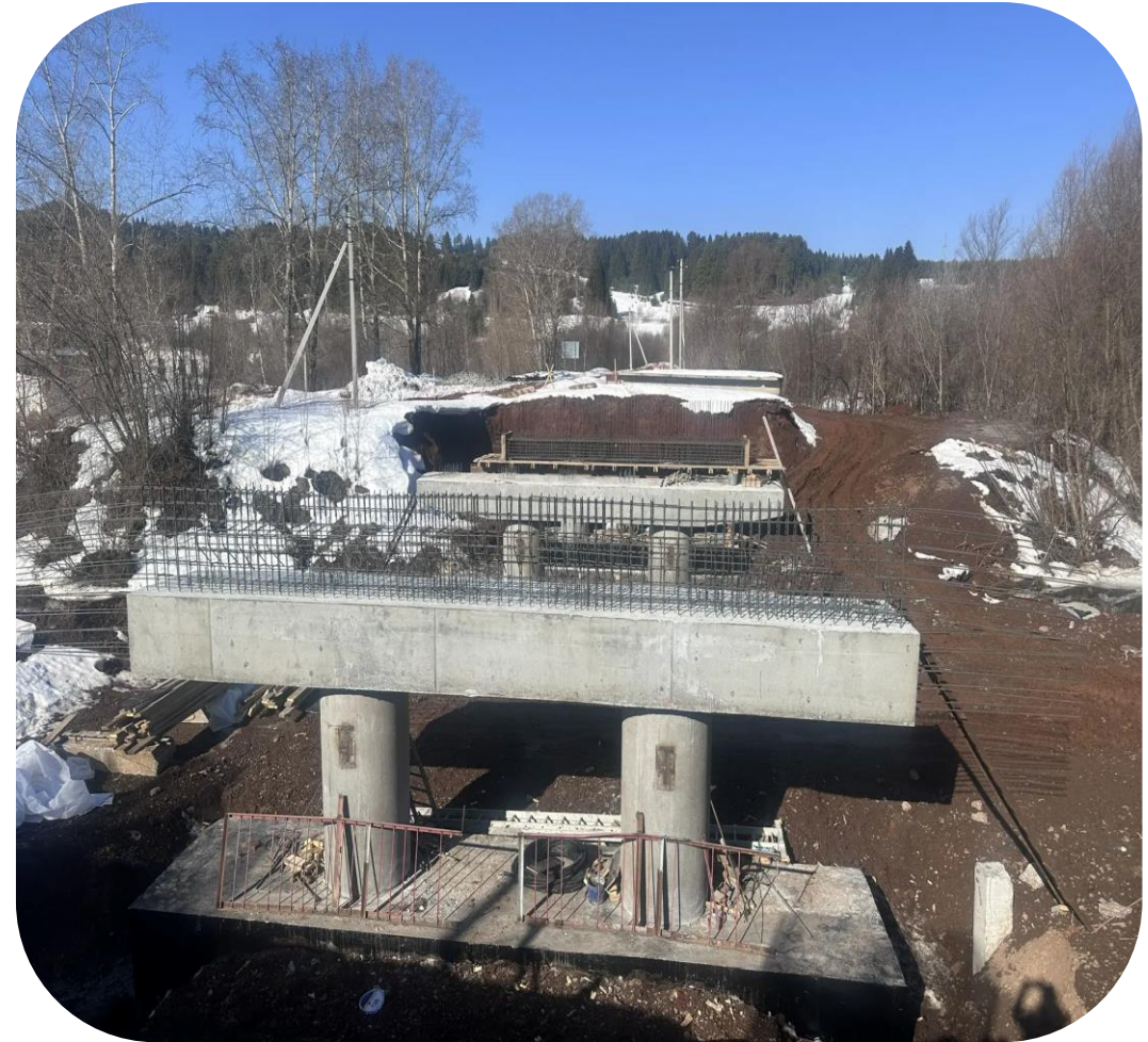
Ремонт моста через р. Юг по ул. М. Маркова в п. Юго-Камский
